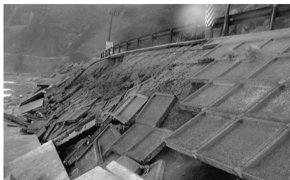
写真-1 冬期風浪に伴う高波浪により被災した道路(新潟県相川町 主要地方道佐渡一周線)
