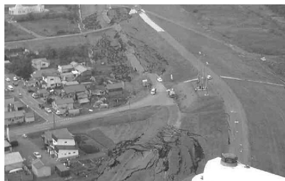
写真－11 地震により被災した堤防 （北海道豊頃町 一級河川十勝川）
