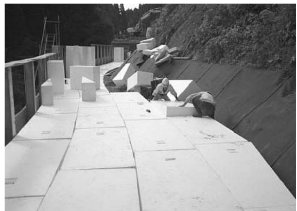
写真 2 発泡スチロール施工状況
