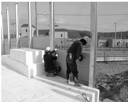
写真 1 壁面材施工状況
