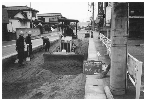
写真 3 路盤工（ブルドーザによる敷均し転圧）
