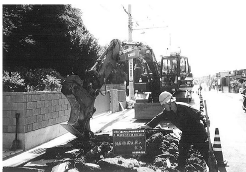
写真 2 とりこわし工（コンクリート圧砕機）
