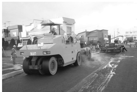
写真 4 舗装工（ローラによる敷均し）
