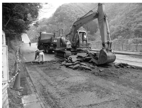
写真 1 とりこわし工（バックホウ直接積込み）
