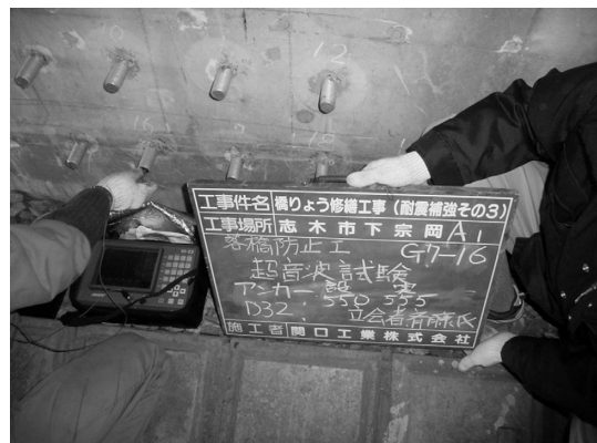
写真-4 超音波試験の現場立会
