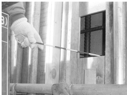
写真-3 狭小部の投入口設置
