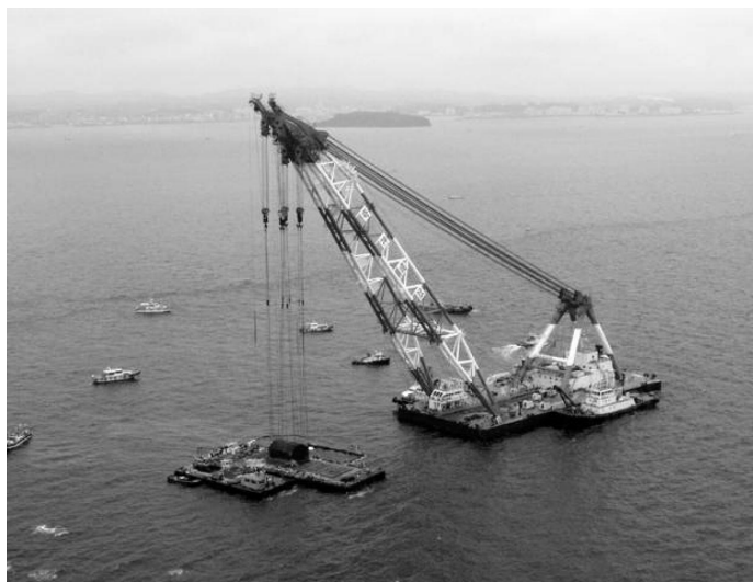
写真—4 第三海堡構造物撤去状況
