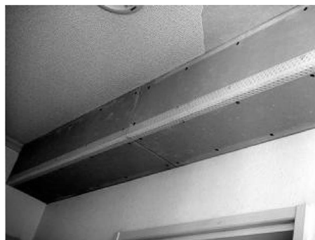
図—5 ダクト式3種換気施工状況（左：ファン本体，右：ダクト隠し用下がり天井）
