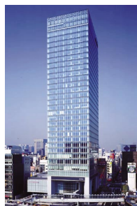
写真-3 秋葉原クロスフィールド(2005年竣工)
