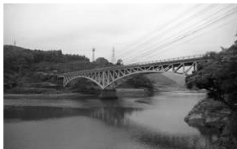
写真—4 現在の美々津橋 (下流左岸から)
