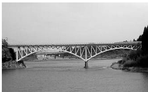
写真—1 現在の美々津橋（上流から全景）
