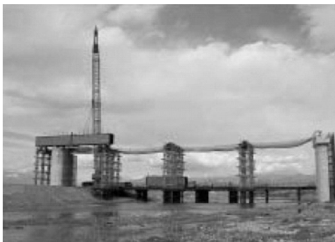
写真 1 クレーンによる架設
