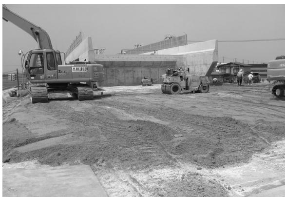
図 7 軽量盛土施工状況
