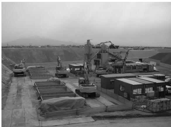
図 6 軽量土攪拌混合槽
