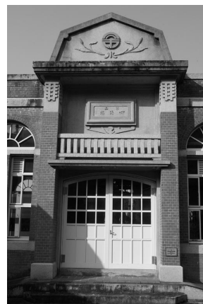
旧ポンプ棟入口
