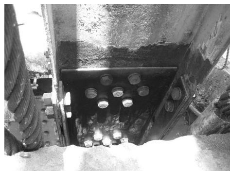
写真 5 破断部の補強状況（本荘大橋）
