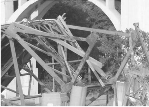
写真 3 事故橋梁の腐食状況
