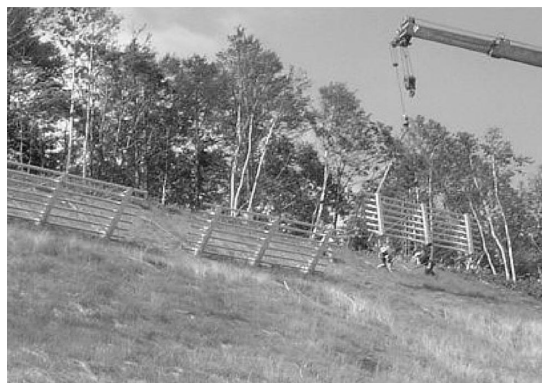
写真-6 柵の設置・完成後（吊柵）
