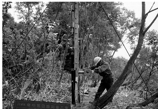
写真－３ アンカー打込み（吊柵）
