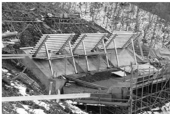
写真－２ 設置後（固定柵）
