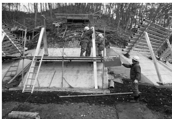
写真－１ 組立・設置（固定柵）
