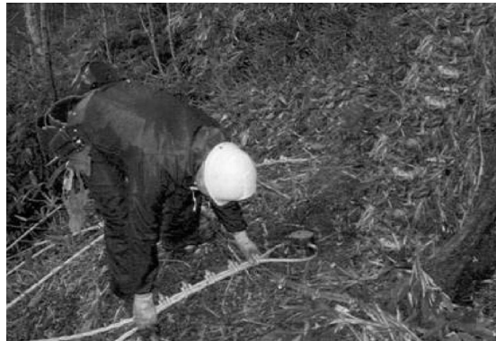
写真－４ アンカーとワイヤロープの連結（吊柵）
