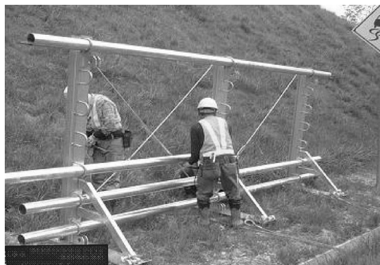
写真-5 柵の組立（吊柵）
