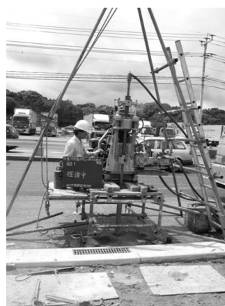
図 3 地盤改良土の採取(イメージ)
