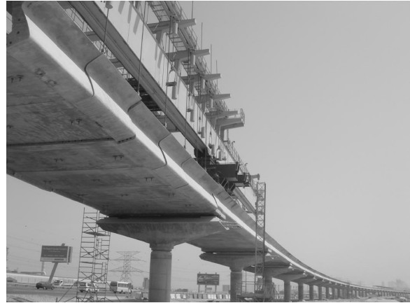
写真 2 高架橋施工状況
