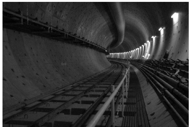
写真 3 トンネル部現況
