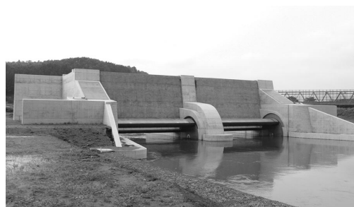
(D) 鴛波側水門
