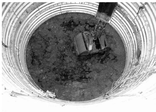
写真 2 クラムシェルによる掘削
