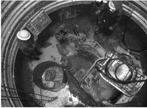
写真 4 小型バックホウ掘削
