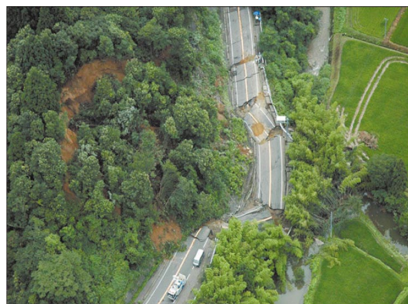
長岡市大積千本町における 国道8号被災状況 「写真提供：朝日航洋」
