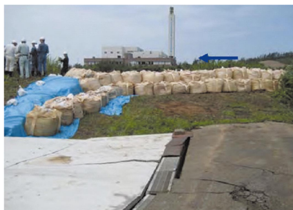
大型土のうによる応急復旧 鯖石川（柏崎市橋場町）
