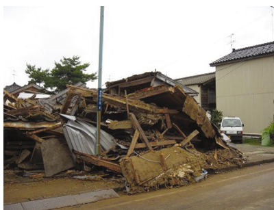
新潟県柏崎市住家被害状況
