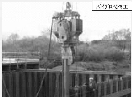
図 5 工種名：鋼矢板（H形鋼）工（パイロハンマ工）
