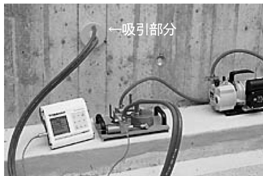
写真 1 トレント法の測定状況
