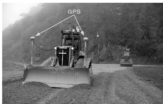
写真 1 RCC 敷均し状況
