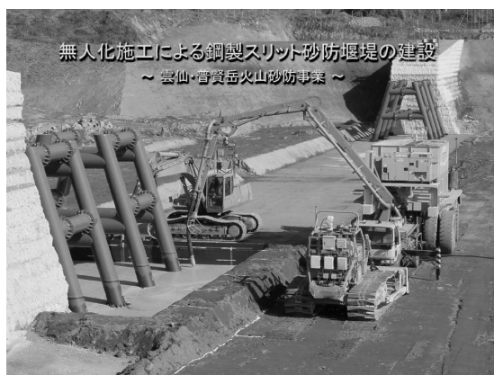
写真 3 スリットダム施工状況
