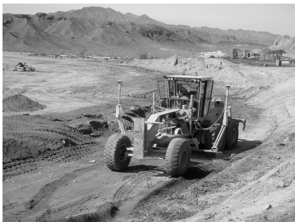
写真－2 3D-MCによる大規模ゴルフ場造成工事
