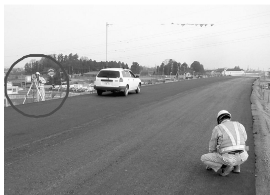
写真—3 TSによる出来形計測状況
