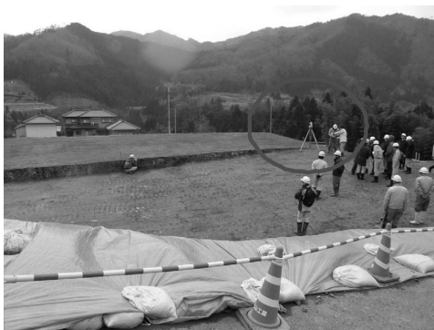
写真—2 TS による出来形計測状況
