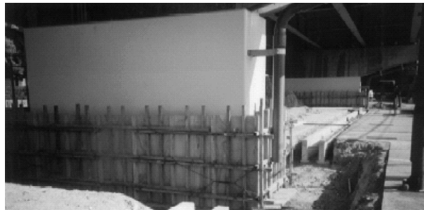
写真－５ 根巻きコンクリート
