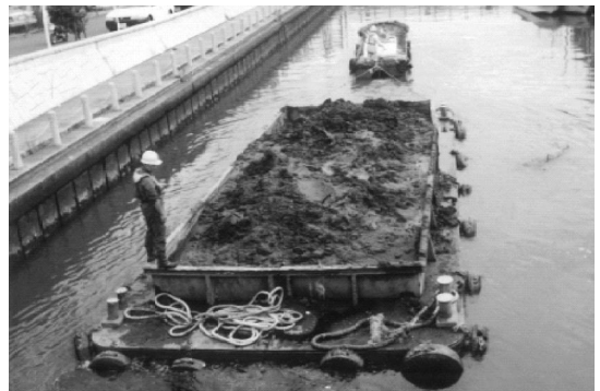
写真－5 浚渫土運搬
