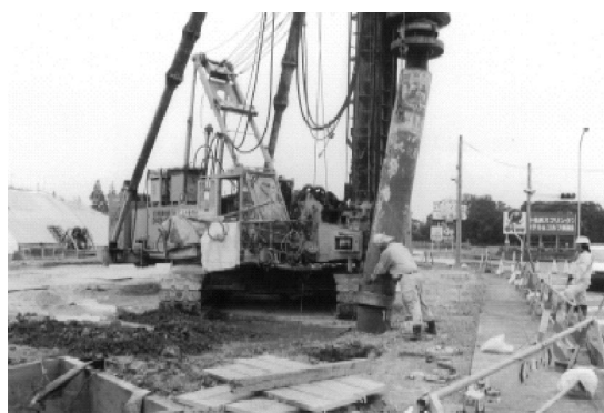
写真－4 ヤットコ打込み準備
