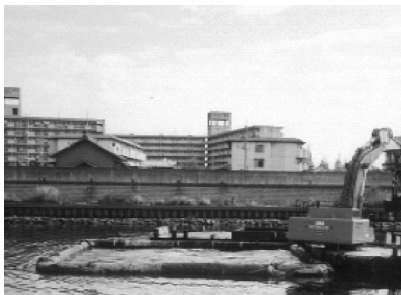
写真－4 汚濁防止枠
