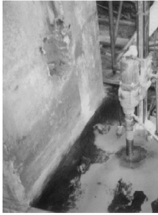
写真－１ フーチングアンカー削孔
