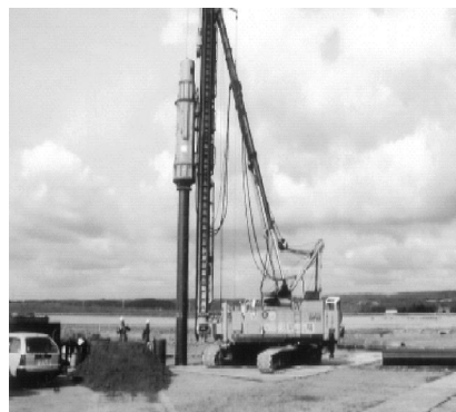
写真－2 杭打込み（鋼管杭）
