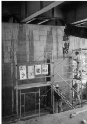
写真－３ 鋼板施工
