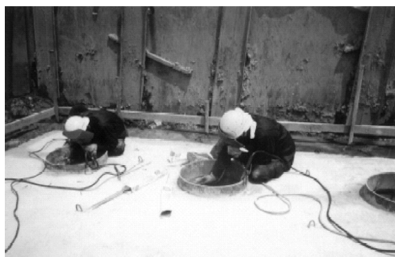
写真－5 杭頭処理
