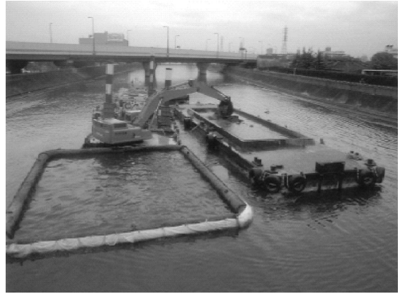
写真－2 浚渫作業②
