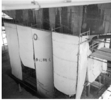
写真－２ 足場設置
