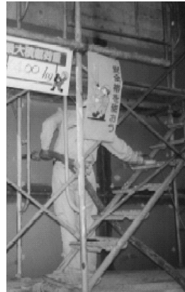
写真－４ 樹脂注入
