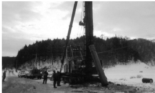
写真－1 杭吊込み芯出し（鋼管杭）
