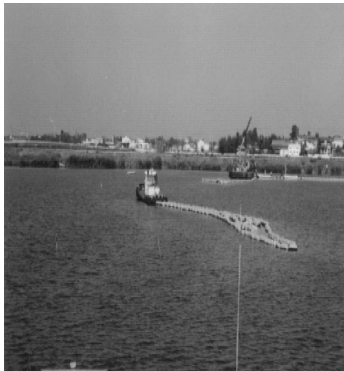
写真－3 汚濁防止膜設置
