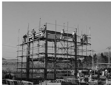
躯体基礎コース
