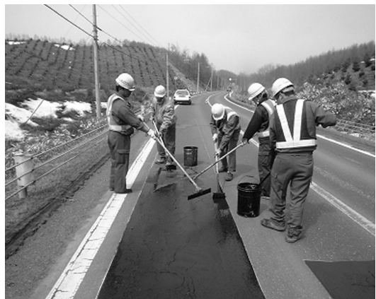
写真 2 瀝青材塗布作業(流動個所)
