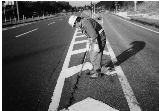
写真 1 施工面清掃作業(クラック)
