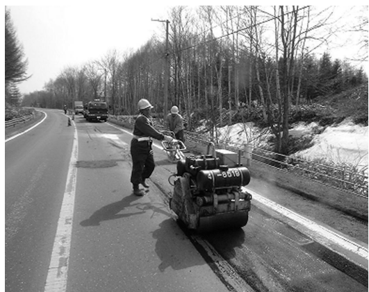
写真 4 締固め作業(流動個所)
