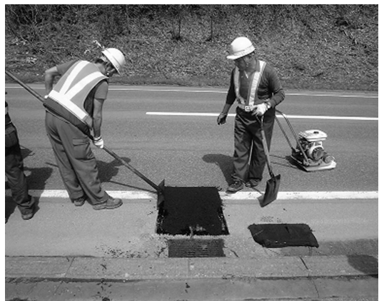
写真 3 合材敷均し作業(ポットホール)
