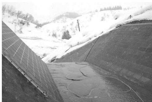
写真-2 完成後の状況
