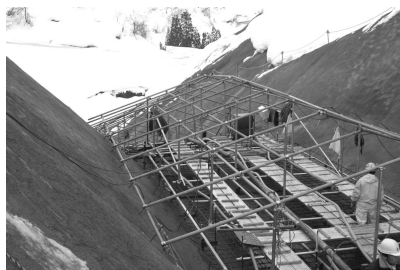
写真-1 準備工の状況
