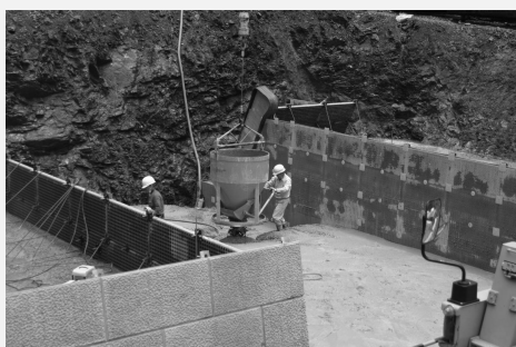
写真-7 生コン打設→
