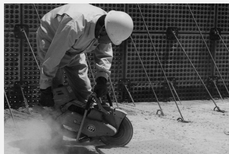
写真-6 型枠パネル切断加工→
