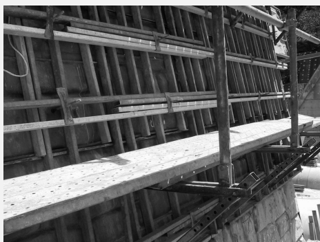
写真-9 従来工法施工状況
