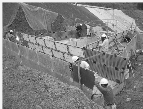
写真-10 残存型枠工法施工状況
