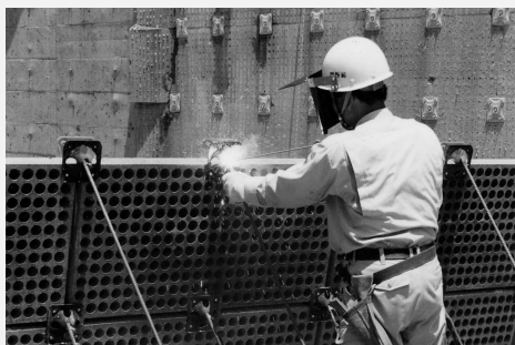
写真-5 セパレーター溶接→
