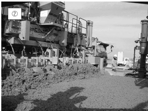
図 6 ①上層敷均し(プレーサスプレッタ)②コンクリート締固め③コンクリート成型(②③:スリッパフォームペーバ前面・背面)
