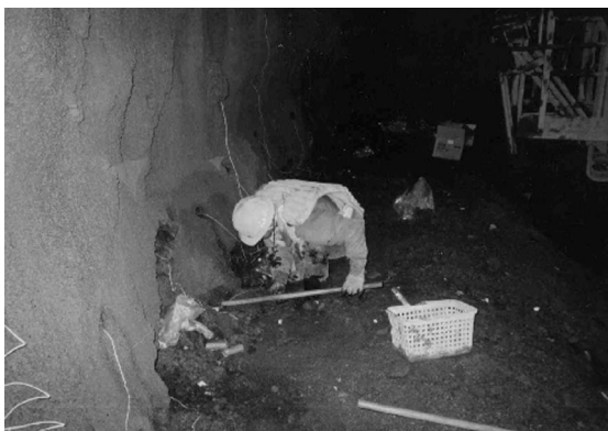
写真 2 人力による装填作業
