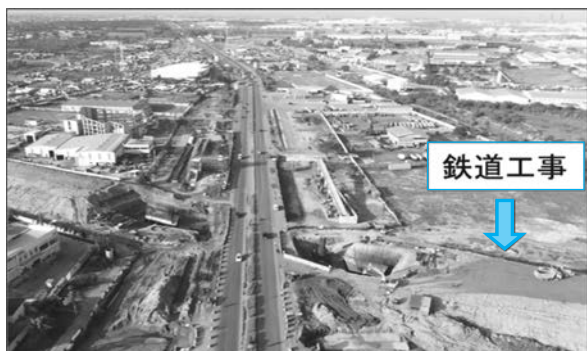
写真-5 鉄道工事との干渉状況
