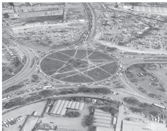
写真－1 着工前のテマ交差点
