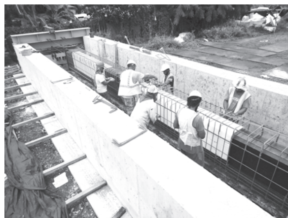
写真－6 プレテン桁の製作（鉄筋組立）
