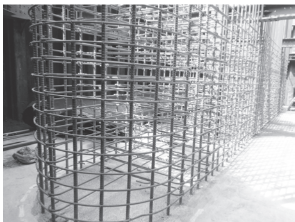
写真－4 エポキシ樹脂塗装鉄筋を用いた橋脚部
