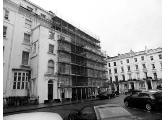
写真-2 ロンドン中心部の集合住宅補修工事用の足場
