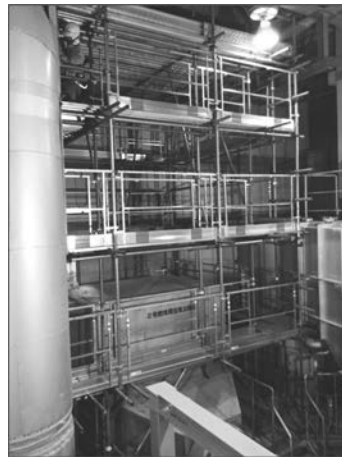
写真-6 改善事例：単管足場・手すり，中棧及び幅木を一体型にした手すり枠の使用
