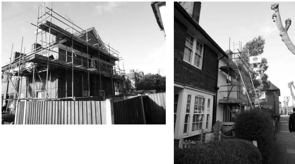
写真-1 ロンドン郊外の戸建て住宅補修工事用の足場
