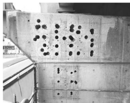
写真-1 既設橋脚の削孔状況
