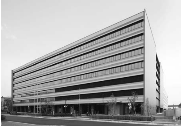
写真-1 庁舎全景
