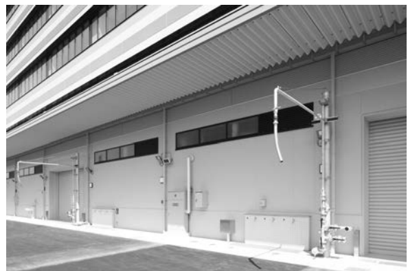
写真－7 給水車への注水設備
