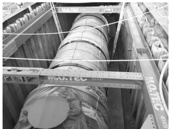
写真－8 耐震貯水槽
