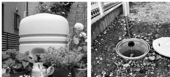
写真-12 個別住宅の貯留浸透施設
