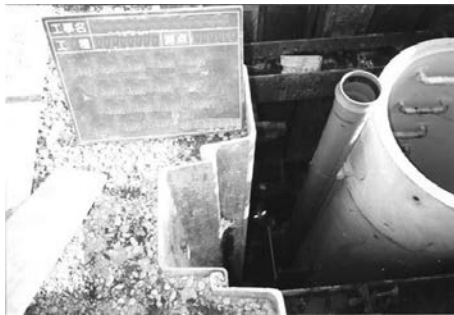
写真－2 外副管取付工の施工状況
