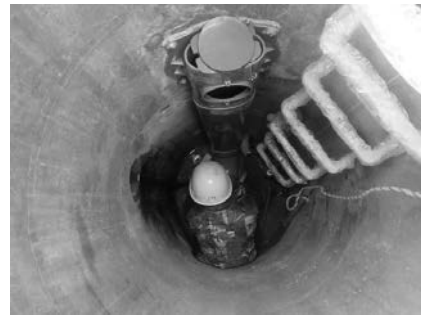
写真－3 内副管取付工の施工状況
