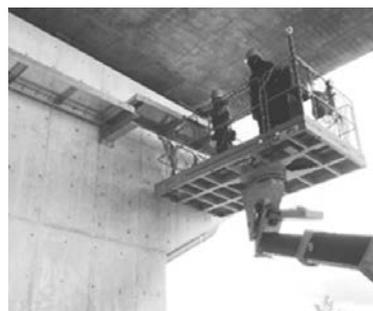
写真-11 検査路架設状況
