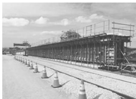
写真－22 主桁製作用型枠（鋼製型枠）
