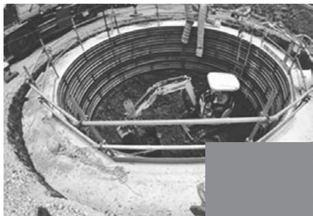
写真-15 小型バックホウによる掘削作業状況
