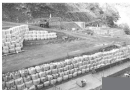
写真－8 大型土のう仮締切設置状況
