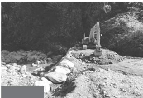
写真－5 土砂による仮締切設置作業状況
