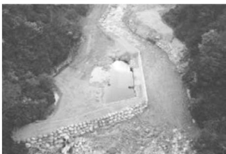
写真－6 土砂仮締切設置状況
