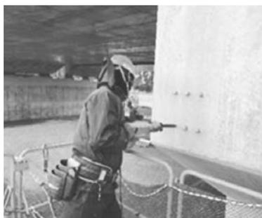
写真-10 アンカーボルト設置状況
