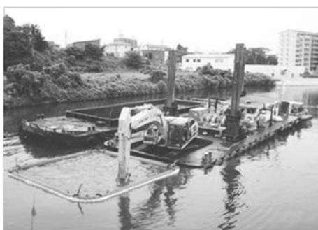
写真－19 バックホウ浚渫船による浚渫作業
