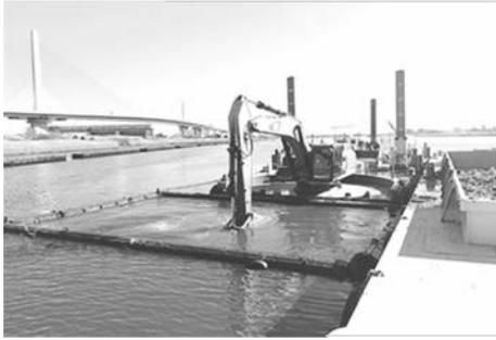
写真-1 バックホウ浚渫船 (ICT) による浚渫状況
