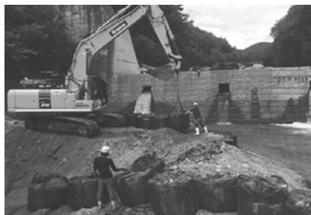
写真－7 大型土のう設置作業状況
