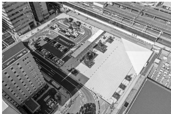
写真-3 整備後の佐賀駅前広場（佐賀城口）全景
