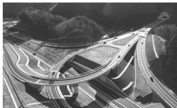
写真-1 釜石IC(岩手県釜石市)
