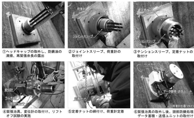
図－8 既設アンカーへの荷重計取り付け手順 7)
