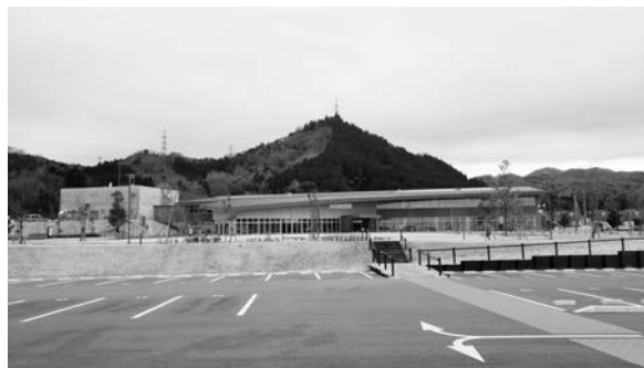
写真-3 太陽光発電システムを導入した大熊町役場庁舎
