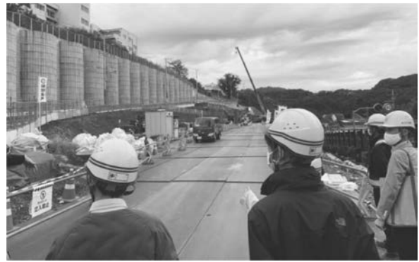
写真－2 道路改良工事現場見学
