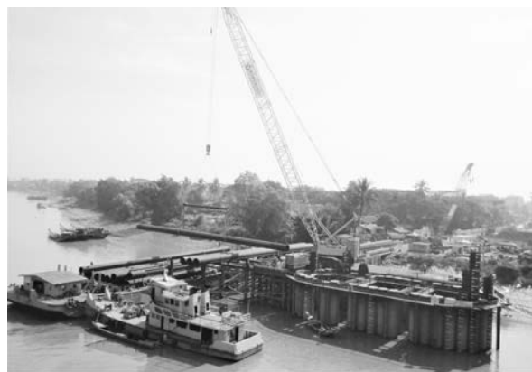
写真-3 鋼管矢板井筒の打設工事
