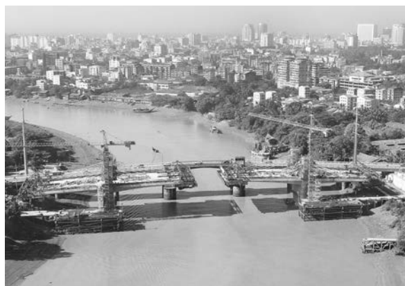
写真-4 PC エクストラロード橋の張出架設工事
