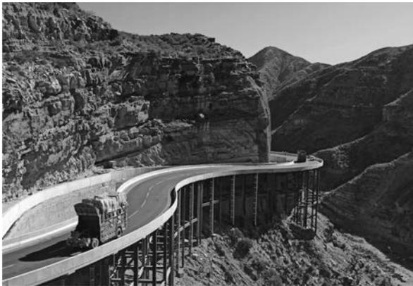
写真-2 鋼製床版拡幅橋梁の完成状況
