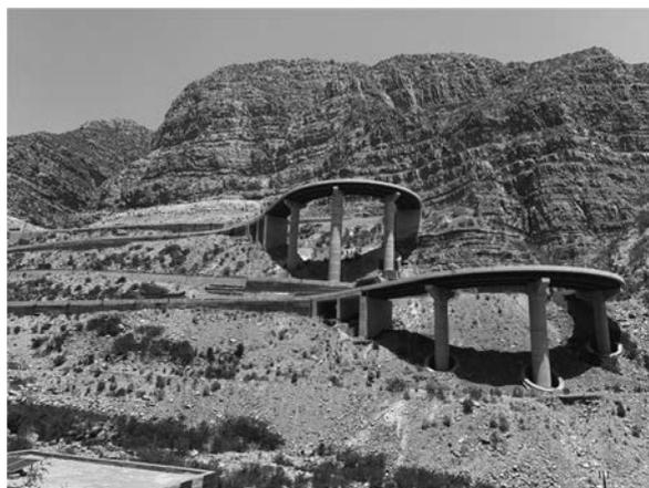
写真-1 鋼箱桁橋梁の完成状況
