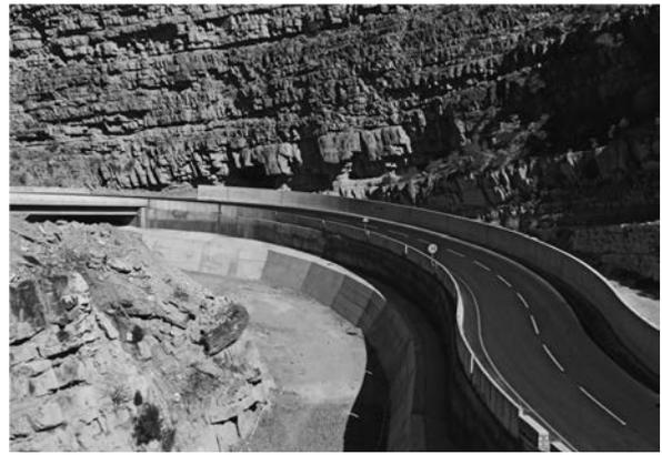
写真-3 補強土壁の完成写真
