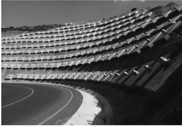
写真-5 グラウンドアンカーの完成状況
