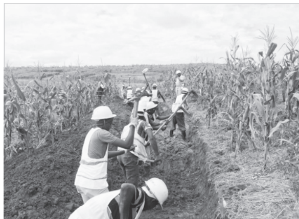
写真－3 人力掘削による用水路の建設状況
