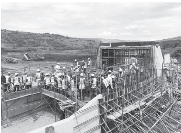
写真－2 バケツリレーによるコンクリート打設状況
