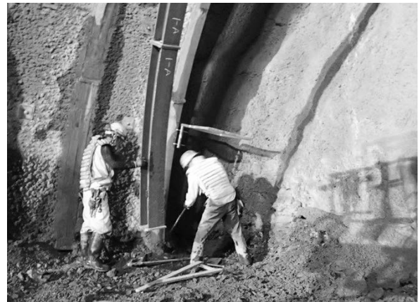
写真－４ 落石防護ブラケット
