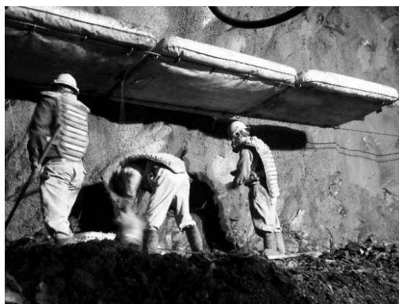
写真－３ 落石防護マット
