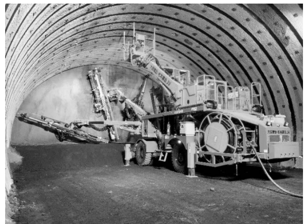
写真－６ ロックボルト打設専用機
