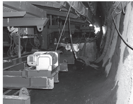
写真-4 自動展張装置による防水シート展張
