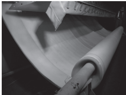
写真-4 自動展張装置による防水シート展張
