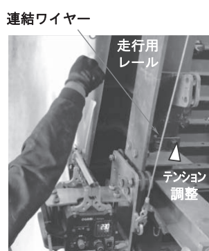
（左）写真-10 テンション確認（工場試験） （中央）写真-11 ワイヤー連結（現場） （右）写真-12 溶着作業（現場）
