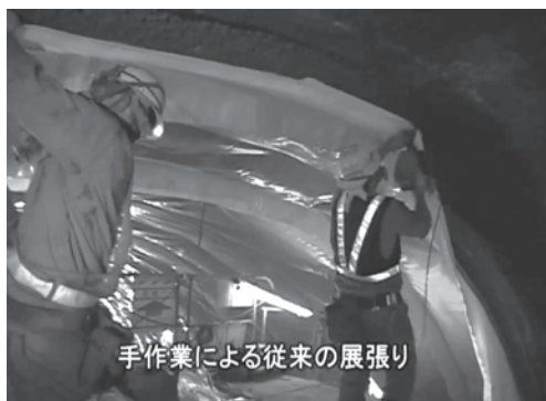
写真-3 従来の人力作業での防水シート展張作業（左：排水型，右：非排水型）
