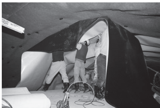
写真-3 従来の人力作業での防水シート展張作業（左：排水型，右：非排水型）
