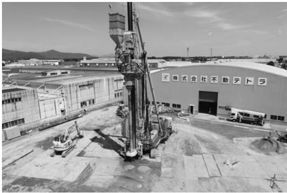
写真-1 SAVE コンポーザー HA 施工状況
