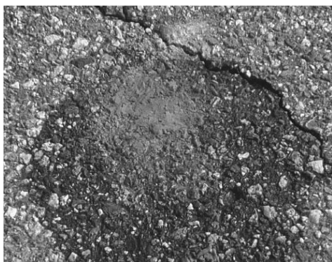
写真-2 調査後の補修状況（上：材料の反力により完全充填 下：充填完了後）
