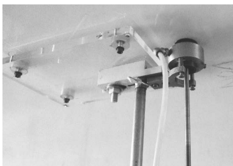
写真-1 調査状況 (上：アスファルト舗装面より 下：鋼板下面から)
