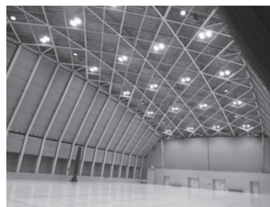
R元 サブアリーナ棟照明改修
