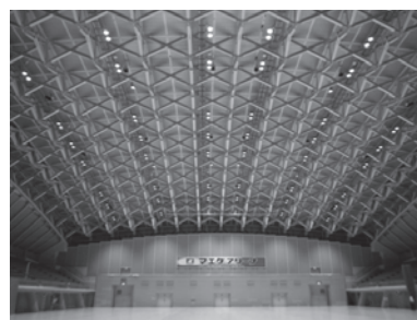
H30 メインアリーナ棟照明改修
