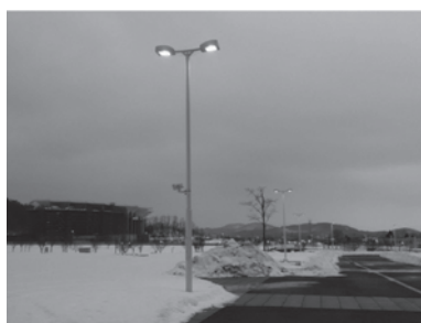
H29 園路灯改修（こもれび広場）
