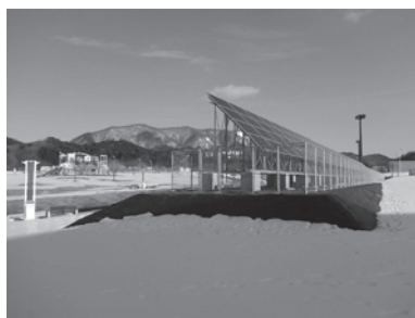
R元 太陽光設備設置（補助競技場）
