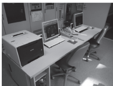
H29～ 中央監視制御装置等改修
